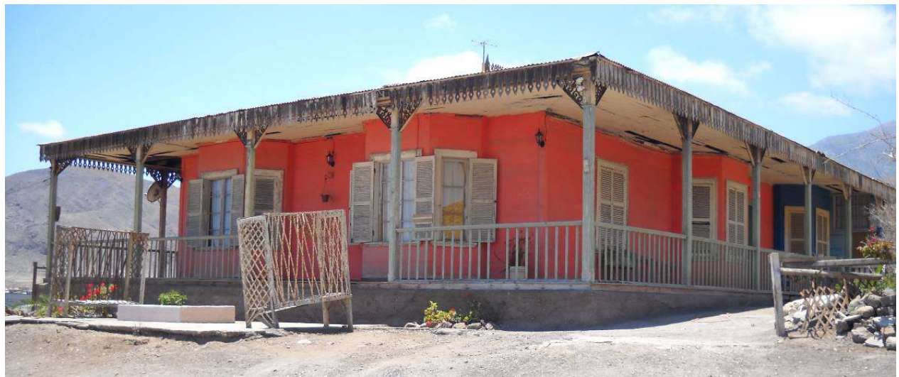
Figura 4.1.-59: Casa Superintendente Locomotoras (Ficha 16)
