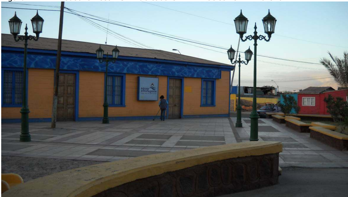
Figura 4.1.-71: Casona Essan S.A. ubicada en Av. Prat con J. A. Moreno
