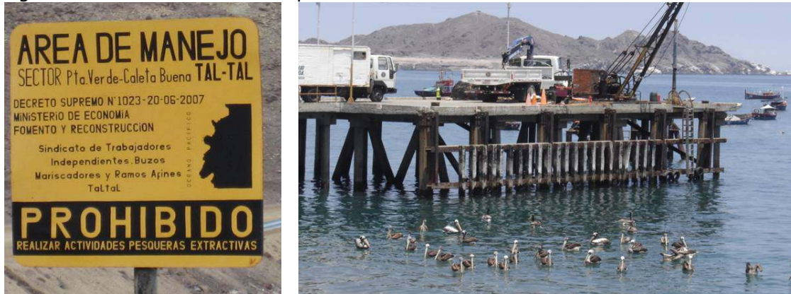
Figura 4.1.-47: Infraestructura portuaria nivel local.
