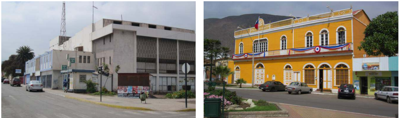
Figura 4.1.-43: Servicios y equipamientos comunales en Taltal.
