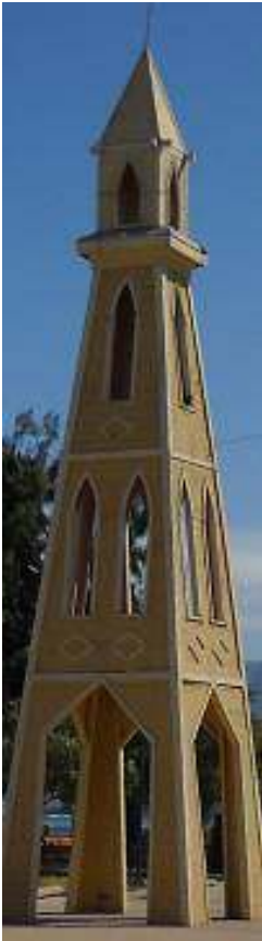
Figura 4.1.-76: Torre del Vigía
